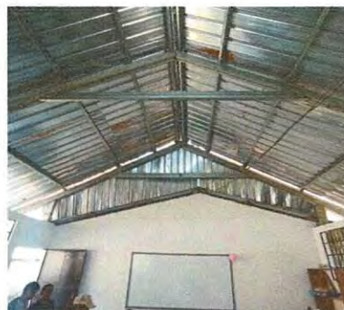
Foto 4: Finalización de instalación de láminas laterales en el techo del aula nueva.
