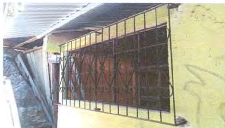
Foto1: Finalización de instalación de una venanta y balcon en la cocina.
