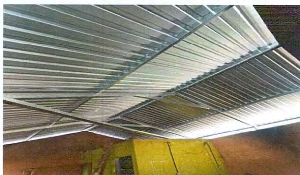
Foto 3: Finalización de cambio de estructura y láminas del techo de la cocina
