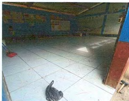
Foto 5: Finalización de colocación piso cerámico en el aula de preprimaria
