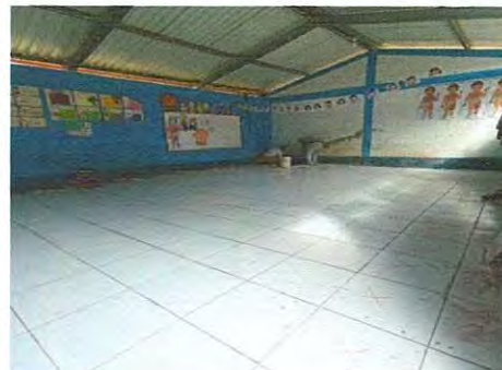
Foto 2: Finalización de istalación de piso cerámico en el aula de preprimaria.
